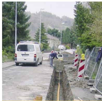
Nach der Verlegung wird die neue Gasleitung exakt vermessen, so dass bei späteren Baumaßnahmen keine Beschädigungen entstehen.
