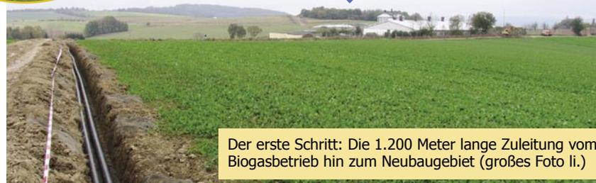
Der erste Schritt: Die 1.200 Meter lange Zuleitung vom Biogasbetrieb hin zum Neubaugebiet (großes Foto li.)
