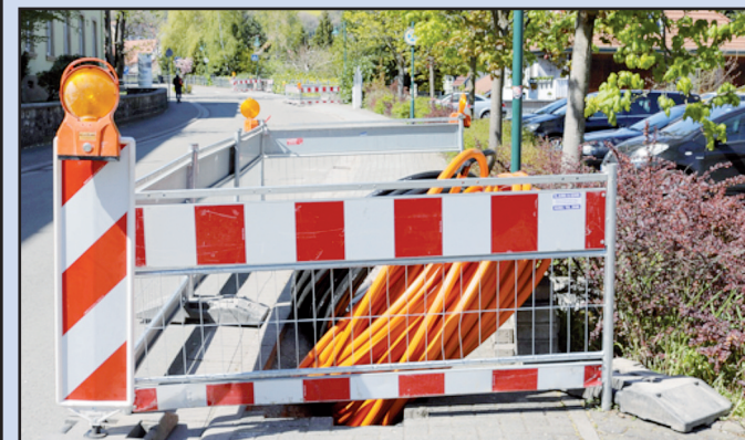
Die Verlegung der Leerrohre für Glasfaser in der Lehnstraße in Kusel erfolgt abschnittsweise im Gehweg.
