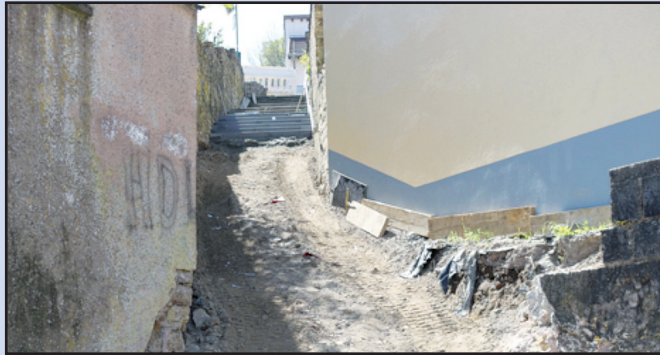
Das „Staffeltreppchen“ hinauf zu katholischen Kirche musste für die Verlegung der Glasfaserrohre komplett entfernt werden und wird mit neuen Stufen bald besser begehbar sein.
