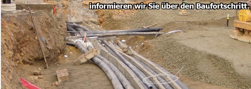
Die Tiefbauarbeiten zur Biomasse-Nahwärmeversorgung Konken sind noch rechtzeitig vor Beginn der kalten Jahreszeit weitgehend abgeschlossen worden. Erste Hausanschlüsse mit Vor- und Rücklauf sind bereits gelegt (oben). Im nebenstehenden runden Bild sehen Sie eine Hauptleitung nebst Hausanschluss im Rohrgraben. Das runde Bild auf der rechten Seite zeigt, dass es im Untergrund bisweilen sehr eng geworden war.
