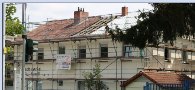
Das Dach des Verwaltungsgebäudes wird mit gedämmten Dachpaneelen belegt.
