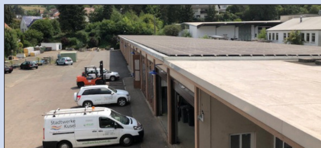
PV-Anlage (79 kWp) auf dem Flachdach der Hallen
