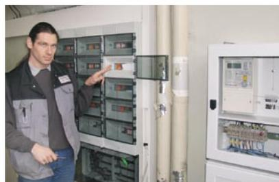
Das Einspeise- und Messfeld für die PV-Anlage auf dem Dach der Stadtwerke-Halle wurde mit eigenem Personal erstellt.
