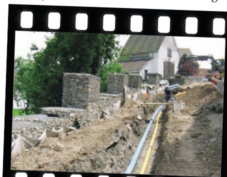
Kusel, Schleipweg, neue Wasserleitung
