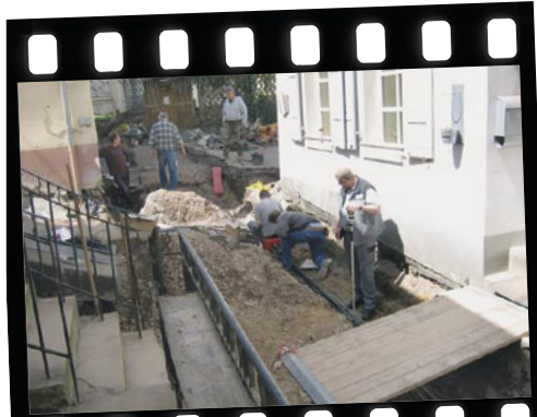
Kusel, Ziegelgasse, Kabelverlegung
