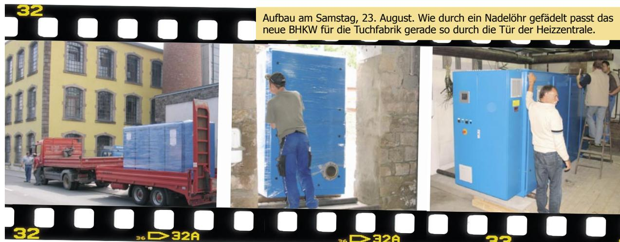
Aufbau am Samstag, 23. August. Wie durch ein Nadelöhr gefädelt passt das neue BHKW für die Tuchfabrik gerade so durch die Tür der Heizzentrale.
