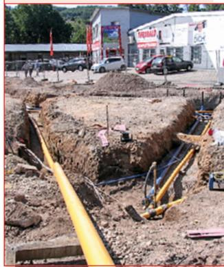
Auch in der Einfahrt zum Gewerbegebiet auf Höhe des Friedhofes wird gearbeitet. Hier mussten die Gas-, die Wasser- und auch die Gas-Hochdruckleitung zur ehem. Kaserne neu verlegt werden. Grund hierfür war die Verlegung von zusätzlichen Schmutz- und Regenwasserkanälen. Hierfür wurde mehr Platz im Untergrund benötigt.
