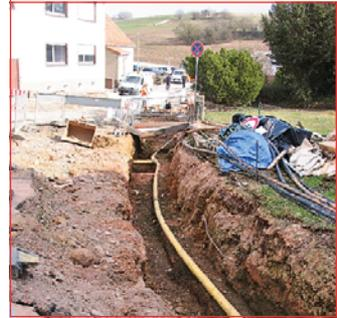
Aber auch außerhalb von Kusel werden Baustellen betretet: In Konken wird derzeit die Albesser Straße ausgebaut, so dass es auch hier zu notwendigen Um- und Neuverlegungen der Gas- und Wasserleitungen kommt. Insbesondere musste die Gasleitung komplett mit einer speziellen Felsschutzmatte umwickelt werden, um eine Tieferlegung zu vermeiden. Die Umhüllung erlaubt nun ein direktes Verfüllen mit Schotter und eine Verdichtung über den Rohren, die den Vorgaben des Straßenbauamtes entsprechen.
