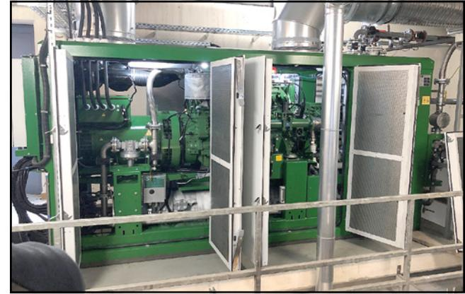
Blick auf Motor und Generator des fertig angeschlossenen BHKW's
