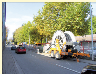
Das Verlegen der voll gedämmten und flexiblen Wärmeleitung erfolgte von der Rolle aus. Damit konnte viel Zeit gespart und der Aufwand für Schweißungen reduziert werden.
