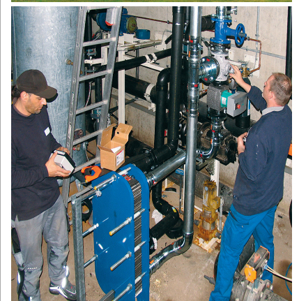
Das Stadtwerke-Team installiert die neue Anlage in der Heizzentrale des Bades.
